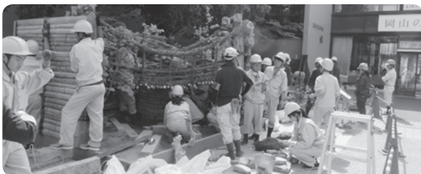
造園(造園工事作業)
