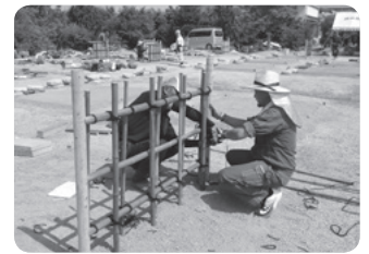
造園 (造園工事作業)
