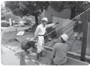
造園 (造園工事作業)
