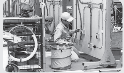
電気工事職種 羽場選手
