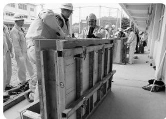
型枠施工
