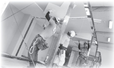
鋼製下地工事試験
