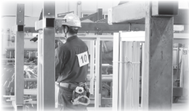
ビル用サッシ施工試験
