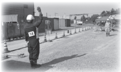
高圧洗浄試験
