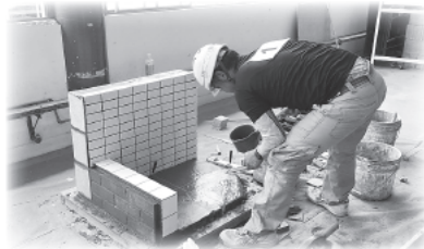
タイル張り試験
