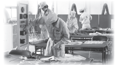
配電盤・制御盤組立て試験
