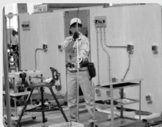
電気工事職種 羽場 選手
