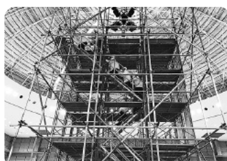
高所体験 (岡山県高土工連合会)
