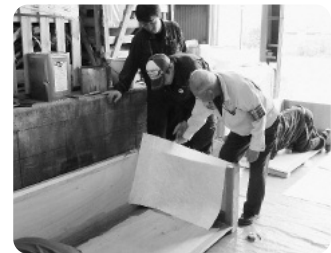
防水施工(FRP防水工事)
